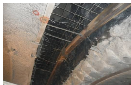
(b) 初支侵限后的换拱处理
